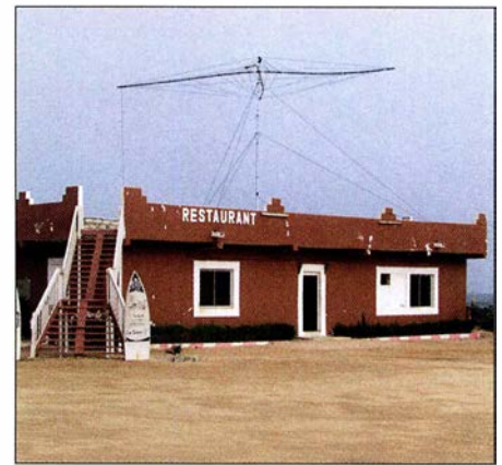
Dank der Treppe hatten wir einfachen und schnellen Zugang zum Dach.
