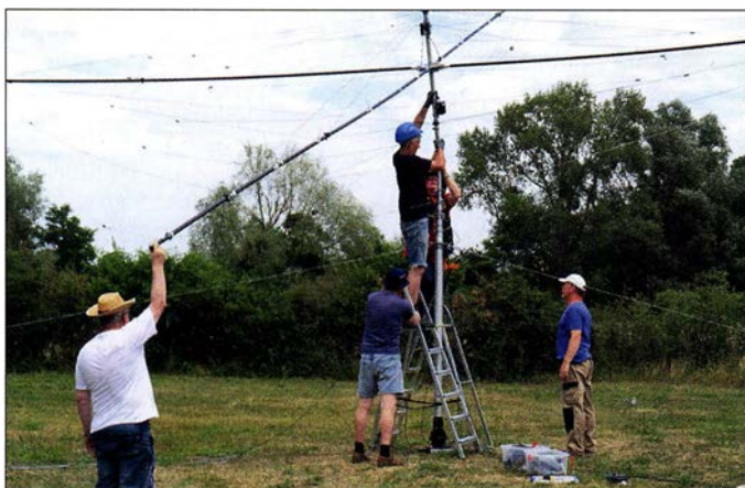
Antennenteam bei der Arbeit
